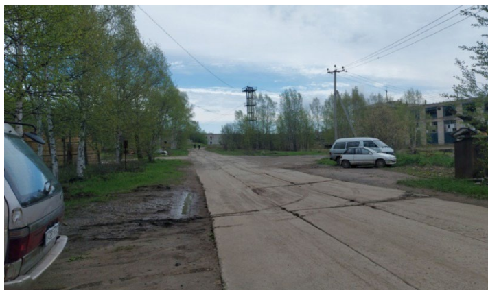
Рисунок 3.5 – Подъезд к территории ООО «Норд+»
