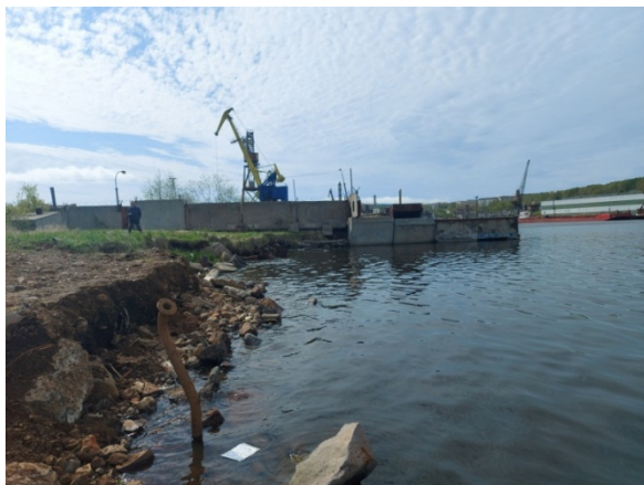
Рисунок 3.3 – Вид на территорию ООО «Норд+» с севера
