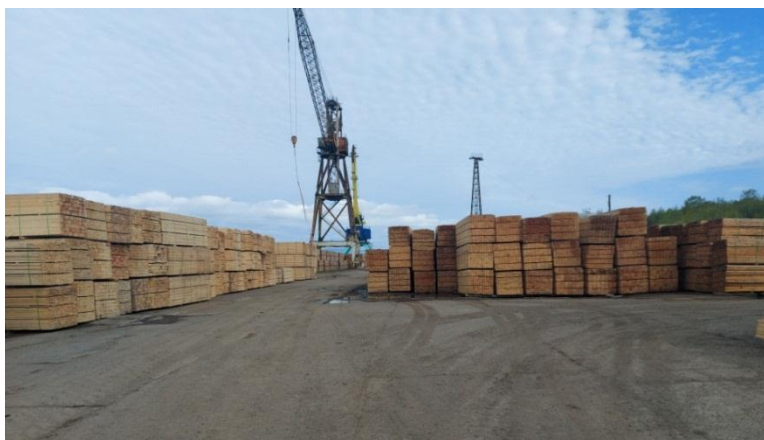
Рисунок 2.1 – Общий вид причала
