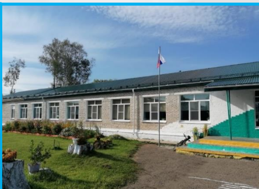
Ремонт кровли школы №12 села Гатка
