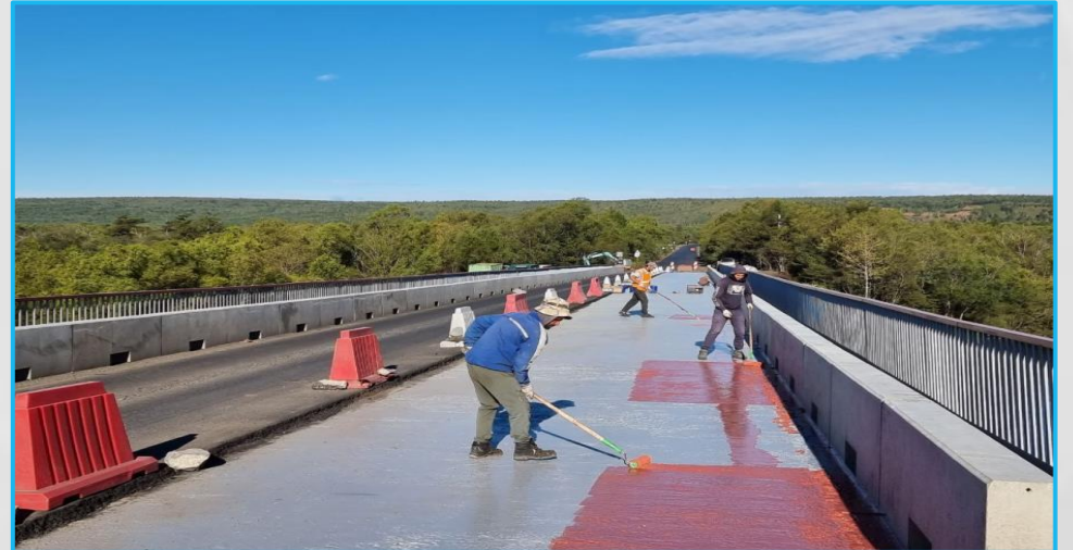
Ремонтные работы на мосту через р. Хадя
