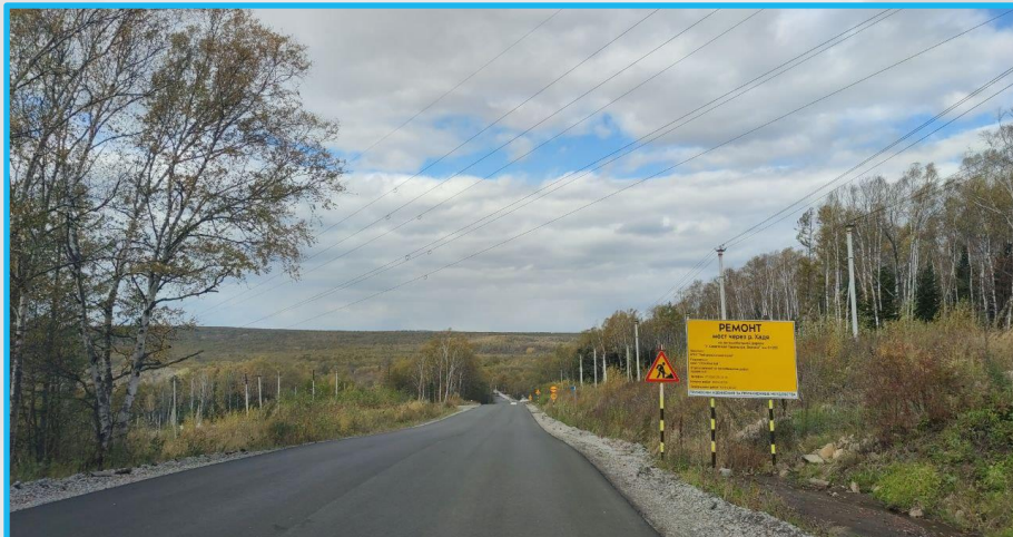
Подъезд к мосту через р. Хадя
