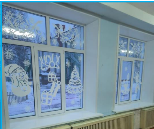
Изготовление и установка окон из ПВХ в детском саду № 39 г. Советская Гавань
