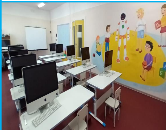
Ремонт кабинета доп. образования в детском саду № 11 г. Советская Гавань
