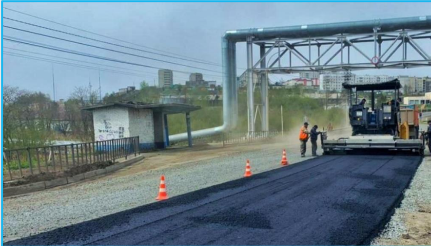
Ремонтные работы в районе «нулевого километра»
